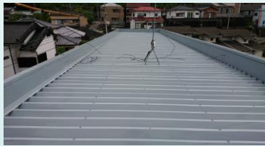
【屋根防水工事】
