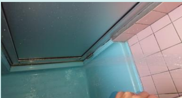
【浴室防水工事】
