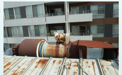
【塗装工事】 施工前
