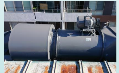
【塗装工事】 施工後
