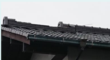
【屋根瓦修繕工事】
