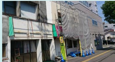
【外壁塗装工事】
